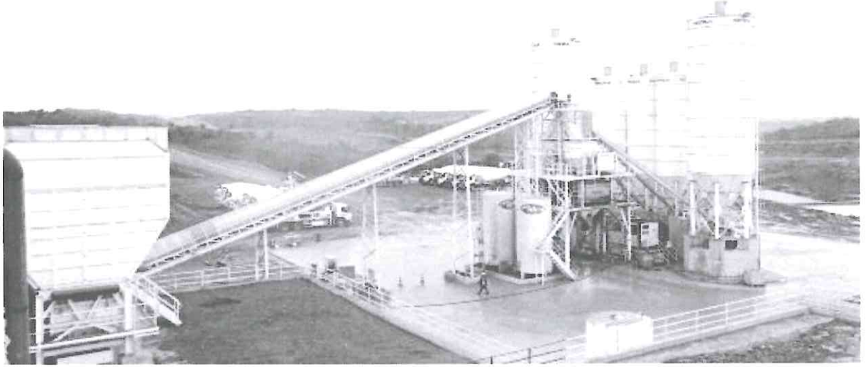
Capital Concrete & Brett Aggregates / Hazır Beton Üretim Tesisi (300 m3/saat kapasitesi ile İngiltere'de tesislerinden) / İngiltere
