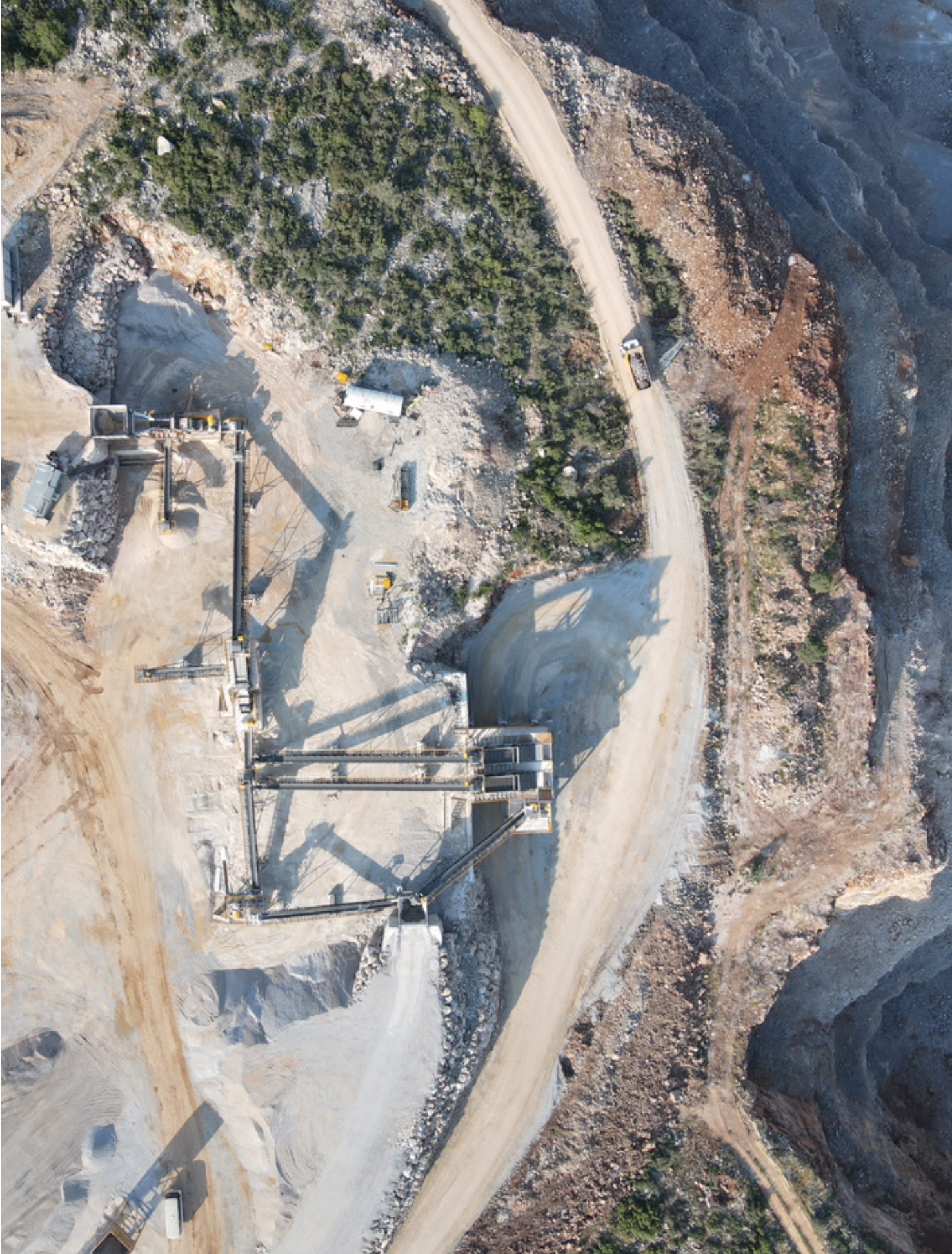
▲ MEKA Agregat Üretim Tesisi Türkiye
